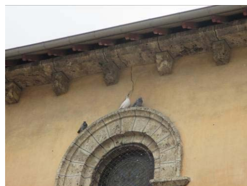
Détail des baies hautes dont les vitraux sont endommagés
