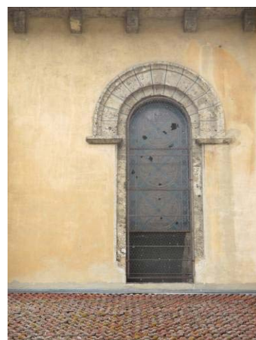
Détail des baies hautes dont les vitraux sont endommagés
