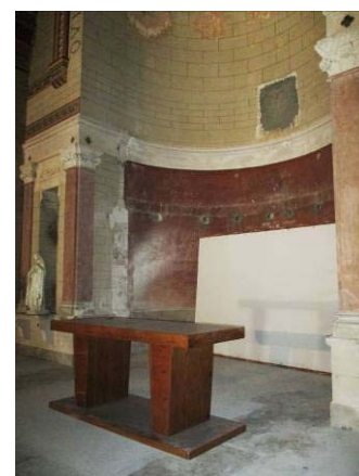
Abside avec traces d'arrachement de l'ancien retable disparu.
