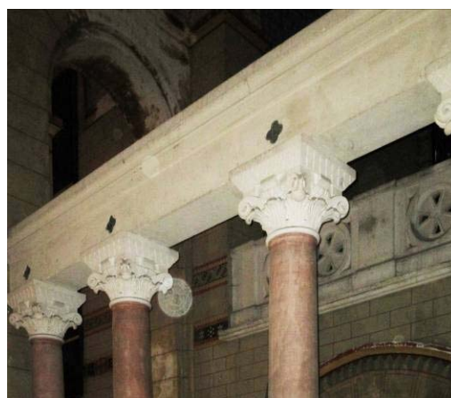
Détail des colonnes en marbre au droit de l'avant-choeur
