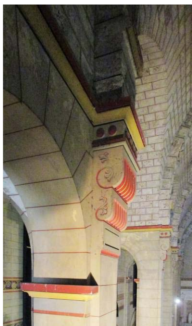
Détail de chapiteau
